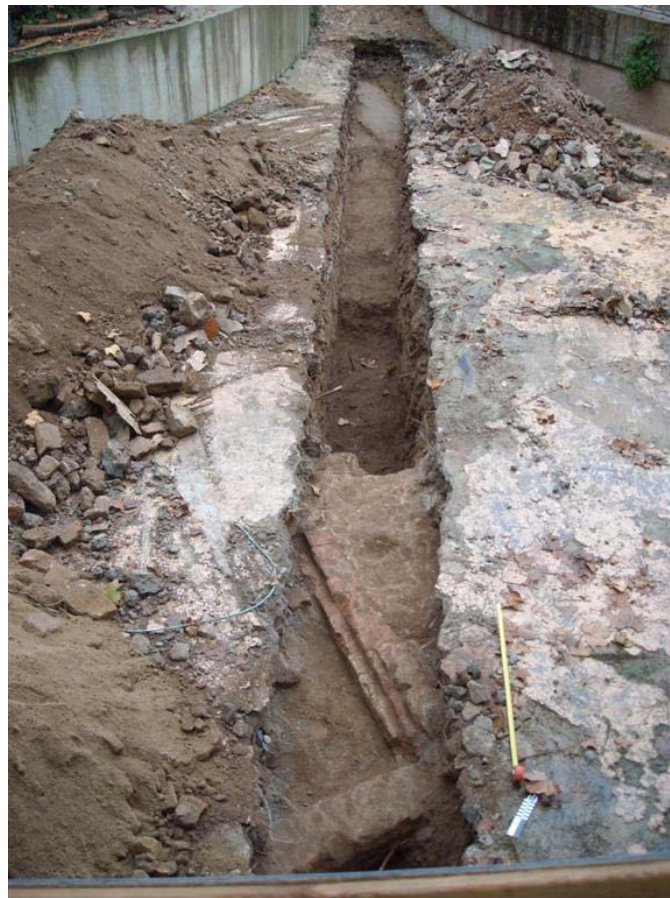
Vista general del sondeig 100
